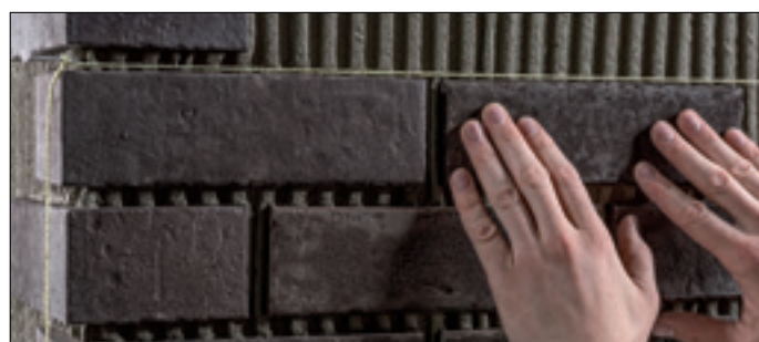
Das Setzen der Flächen-Klinkerriemchen mithilfe einer Schnur. Die Klinkerriemchen werden in das Klebebett eingedrückt.
