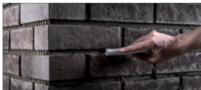
Mit der Kellenverfugung können verschiedene Optiken herausgearbeitet werden.
