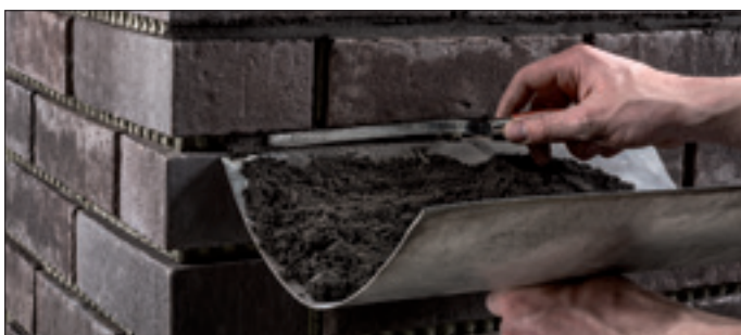
Die Verfugung mittels Fugeisen und Fugblech in der Horizontalen.
