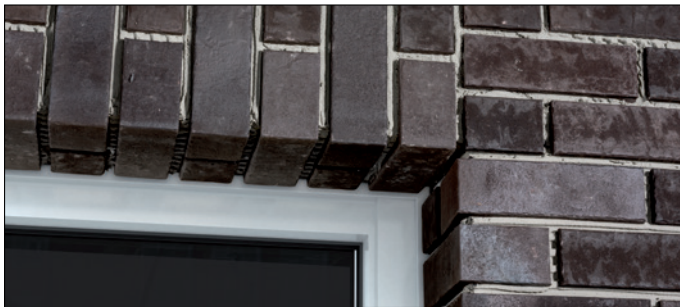
Ein perfekt mit Winkeln nachgebildeter Fenstersturz.
