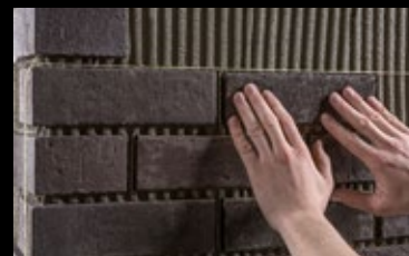
Das Setzen der Flächen-Klinkerriemchen mithilfe einer Schnur. Die Klinkerriemchen werden in das Klebett eingedrückt.
