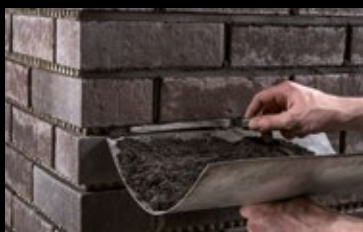
Die Verfugung mittels Fugeisen und Fugblech in der Horizontalen.
