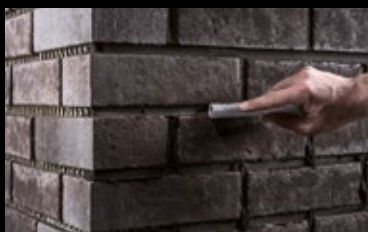
Mit der Kellenverfugung können verschiedene Optiken herausgearbeitet werden.
