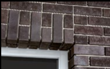
Ein perfekt mit Winkeln nachgebildeter Fenstersturz.
