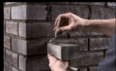
Die vertikalen Fugen lassen sich mit einem kleineren Fugeisen einfacher ausführen.
