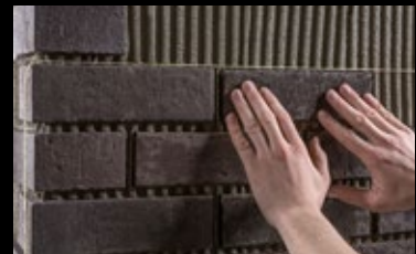
Das Setzen der Flächen-Klinkerriemchen mithilfe einer Schnur. Die Klinkerriemchen werden in das Kleebett eingedrückt.
