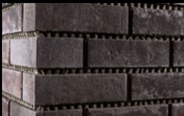
Die fertig verlegte Fläche. Nach Standzeit kann mit dem Ausfügen begonnen werden.
