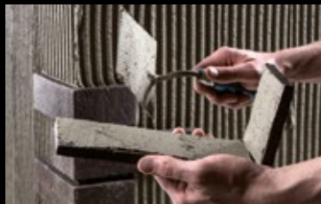
Die Eckwinkel werden im Floating-Buttering-Verfahren verarbeitet.
