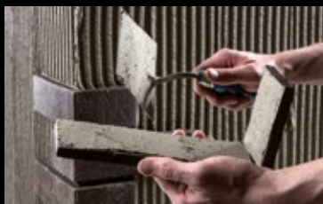
Die Eckwinkel werden im Floating-Buttering-Verfahren verarbeitet.
