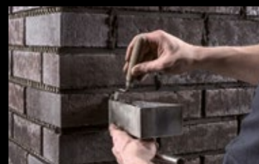
Die vertikalen Fugen lassen sich mit einem kleineren Fugeisen einfacher ausführen.
