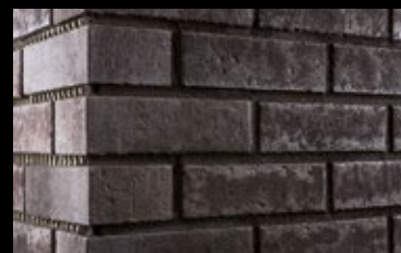
Das fertige Fugenbild. Es werden immer vollständige Seiten ausgefugt.
