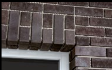
Ein perfekt mit Winkeln nachgebildeter Fenstersturz.
