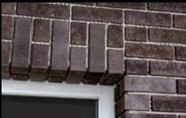
Ein perfekt mit Winkeln nachgebildeter Fenstersturz.
