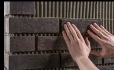
Das Setzen der Flächen-Klinkerriemchen mithilfe einer Schnur. Die Klinkerriemchen werden in das Klebett eingedrückt.
