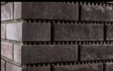
Die fertig verlegte Fläche. Nach Standzeit kann mit dem Ausfugen begonnen werden.
