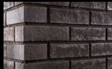
Das fertige Fugenbild. Es werden immer vollständige Seiten ausgefugt.
