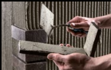
Die Eckwinkel werden im Floating-Buttering-Verfahren verarbeitet.
