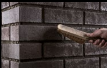
Das Abkehren der Fuge verleiht dieser eine entsprechende Struktur.
