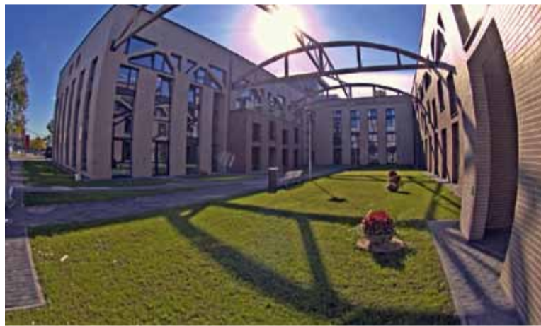
Die für dieses Objekt speziell von STRÖHER entwickelten Klinkerriemchen im Langformat 380 x 52 mm betonen den architektonisch modernen Charakter.
