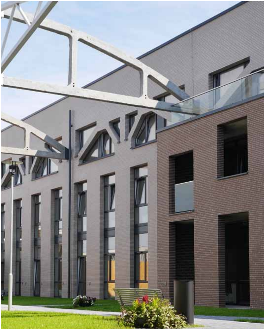
Die für dieses Objekt speziell von STRÖHER entwickelten Klinkerriemchen im Langformat 380 x 52 mm betonen den architektonisch modernen Charakter.
